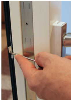
2. Använd ett lämpligt verktyg exv skruvmejsel för att öppna de tre spärrarna (skjuts uppåt).
